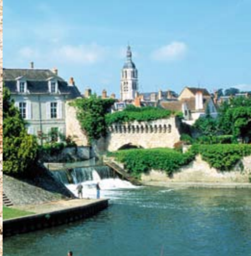
La porte d'eau ou Arche des Grands-Prés qui enjambe le Loir.
